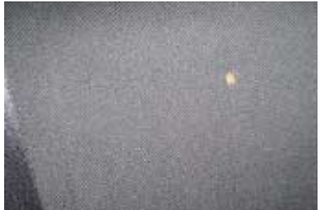
Deze beschadiging is niet acceptabel. Er zit een brandgat in de bekleding.
